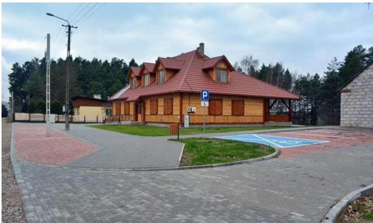
Fotografia 1. Widok na nowo wybudowaną świetlicę środowiskową w Wałkach.
