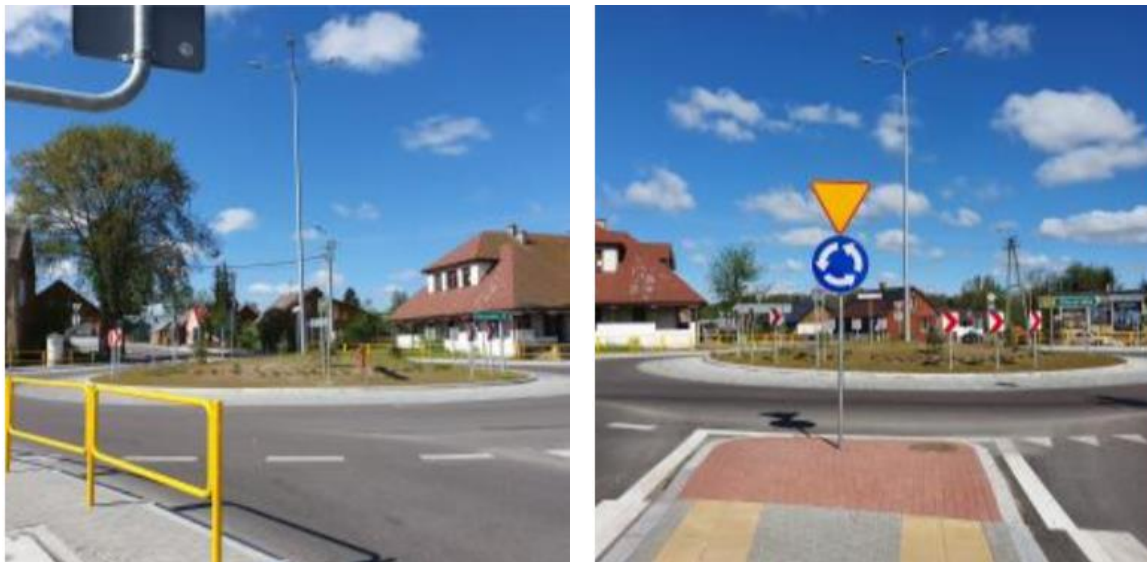
Fotografia 5. Widok na przebudowaną drogę wojewódzką nr 693 w Milejczycach – najważniejszą inwestycję drogową w 2021 roku.
