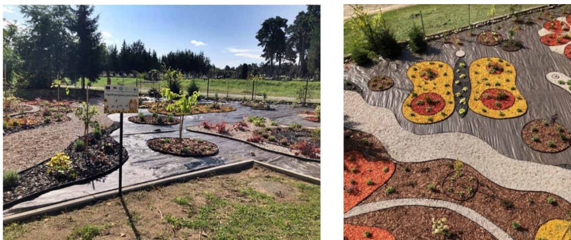
Fotografia 6. Widok na przebieg realizacji projektu "Ogrody przyjazne pszczołom - urządzenie ogrodów ekologicznych na terenie powiatu siemiatyckiego".
